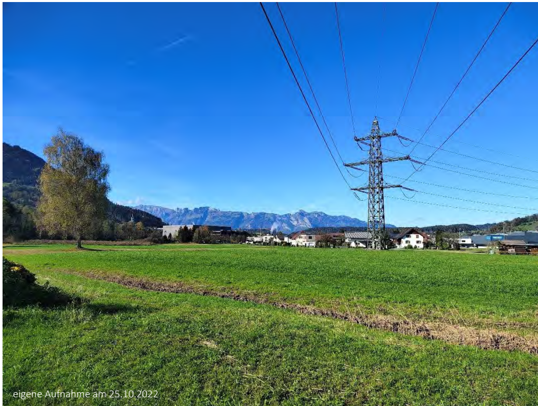
Blick von Nenzing – Heimat Richtung künftigen Heizkraftwerk
