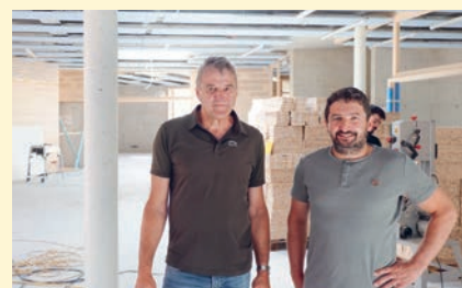
Im Juni war noch einiges zu tun: Robert Hartmann und Bertram Schmid überwachten die Bauarbeiten.
