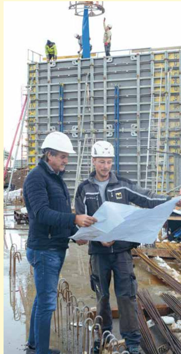
Die Arbeiten für das BIZ Fellengatter laufen nach Plan, bestätigt Bauamtsleiter Ing. Robert Hartmann, hier im Gespräch mit Polier Peter Wüstner.
