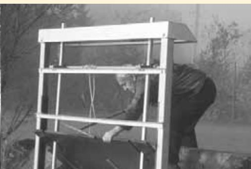
Mit diesen Schleusen wird der Wasserstand gesteuert.
