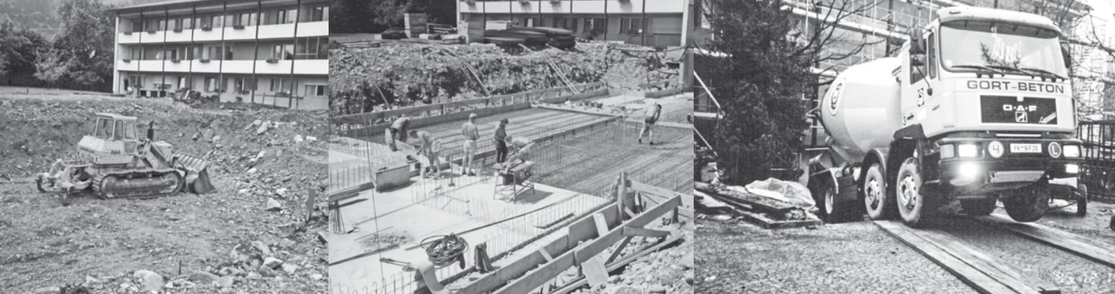
Gleich nach dem Spatenstich wurde mit dem Aushub für den Neubaustrakt begonnen. Das zweite Bild zeigt die Betonierung der Grundplatte. Am 19. Dezember 1995 wurde noch Beton angeliefert: Das Eröffnungsfest fand einen knappen Monat später statt.
