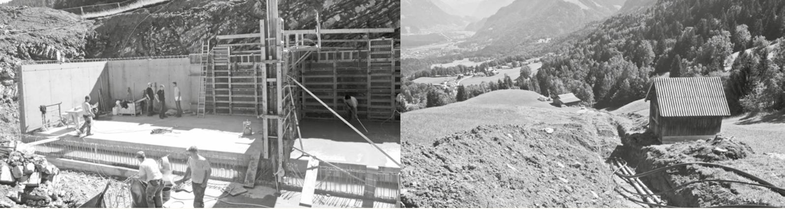
Der Hochbehälter auf dem „Pult“ ist fertiggestellt. Er fasst 360.000 Liter Wasser und sichert damit die Trink- und Löschwasserversorgung von Gurtis und Bazora. Die Druckrohrleitungen von Gurtis zum Hochbehälter werden zur Zeit verlegt.
